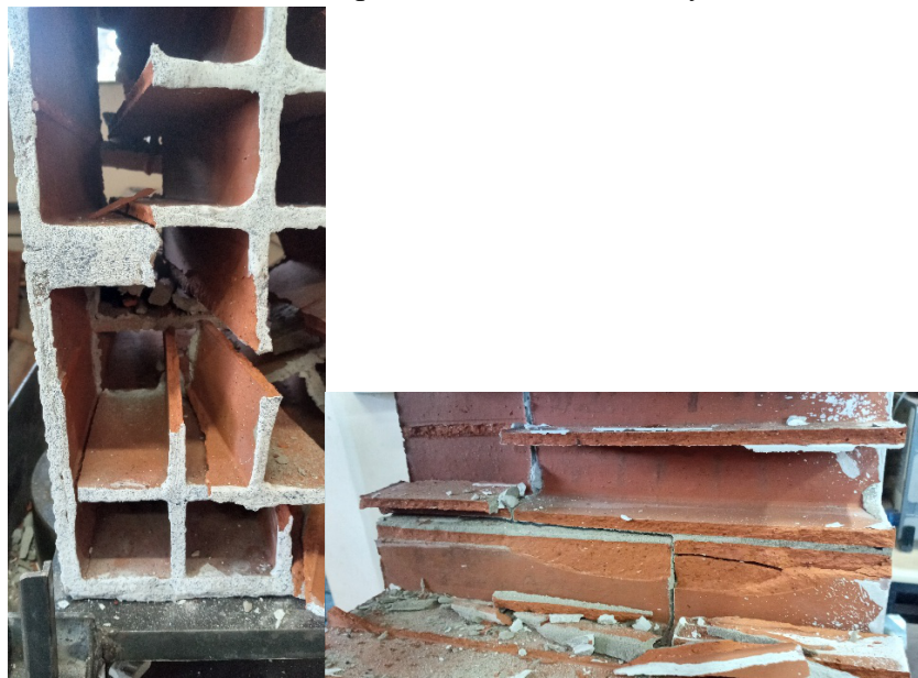
Fig. 12. Modos de falla en celdas CLCH-AC.
