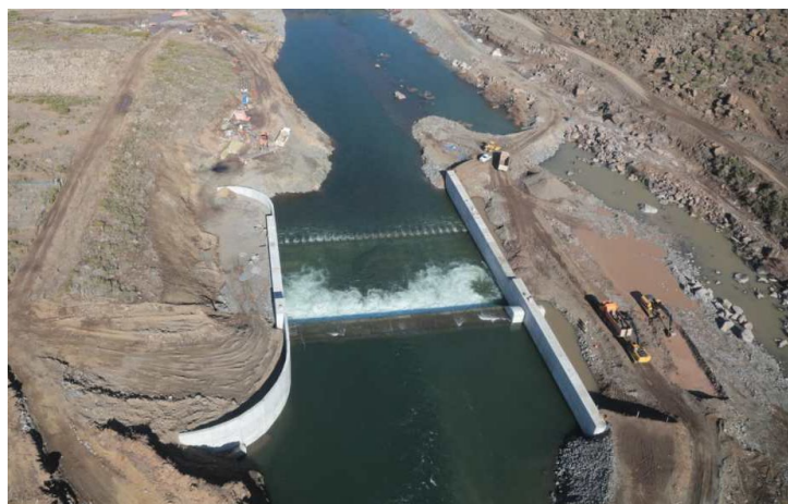
Fig. 2. PAH Nahueve (Prov. de Neuquén) actualmente en construcción.
