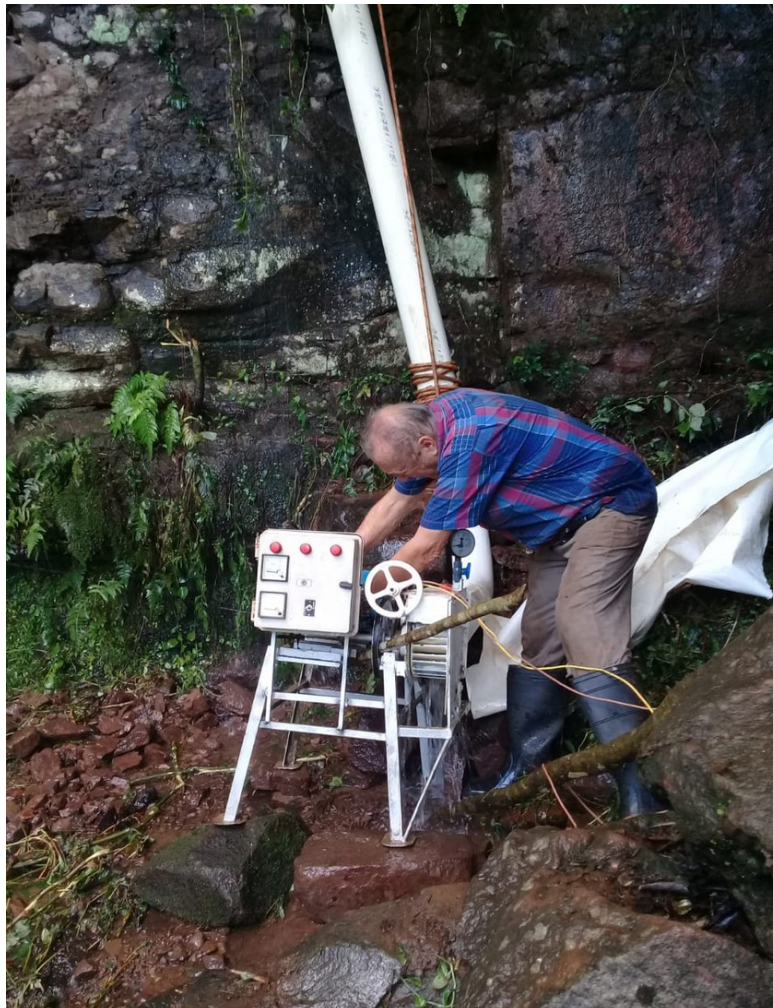
Fig. 4. Ing. Barney realizando la conexión del generador.
